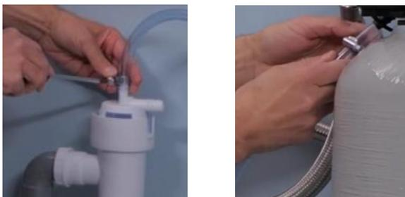
• **ÉTAPE 3** : Installez le régulateur à saumure. Sortez le régulateur à saumure du puits à saumure (cylindre PVC gris) et mesurez la hauteur de la cote «X» à l'aide d'un mètre.
