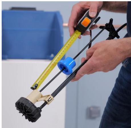
● La cote « X » doit mesurer 110 mm. Réglez-la si nécessaire en faisant coulisser le flotteur bleu sur la tige du régulateur.
