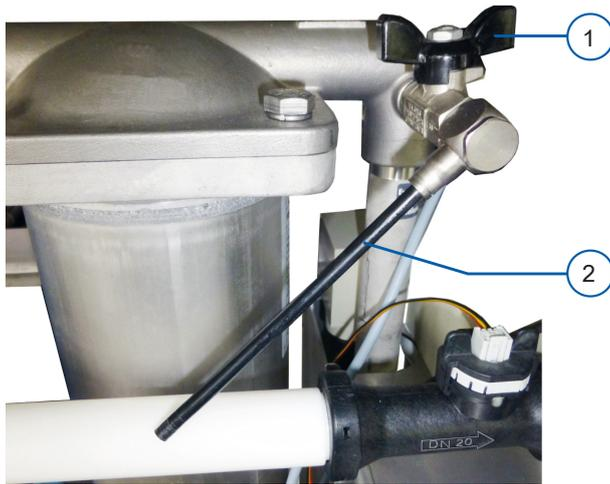
Fig. 27: robinet purgeur de la pompe d'osmose inverse
