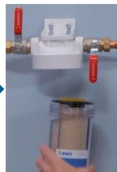
► Retirez la cartouche usagé du bol et positionnez la cartouche neuve sans vous soucier du sens d'orientation. Prenez garde au bon positionnement du joint d'étanchéité noir qui ne doit pas être pincé.
